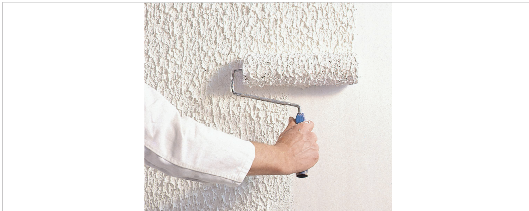
Нанесение Capa-Rollputz с помощью валика.
